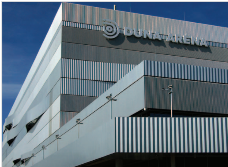
A Duna Aréna épülete Ferencz Marcel tervei alapján épült meg 2015 és 2017 között Fotó: Jászai Csaba © MTI / Jászai Csaba
