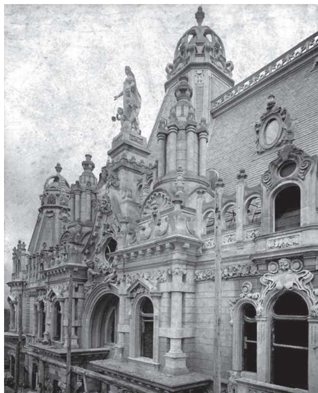
Az Osztálysorsjáték-palota építés közben, Budapest, 1899
